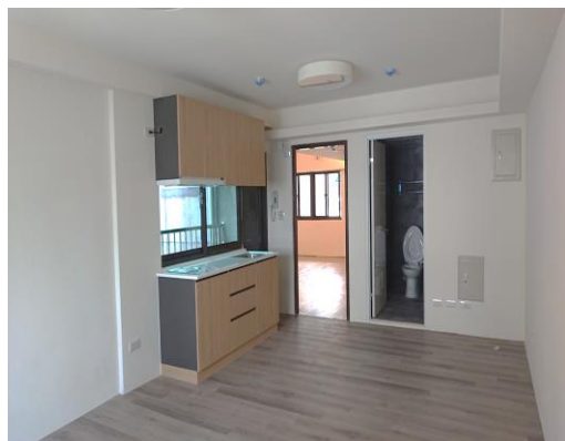
職務宿舍九樓整修工程
