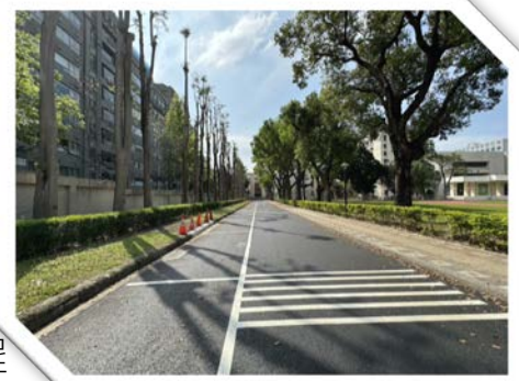
▲ 112年熾陽大道瀝青混凝土路面更新工程
