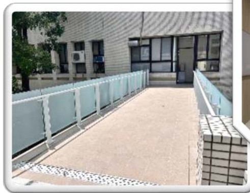
▲ 111年教學大樓至行政大樓連廊工程
